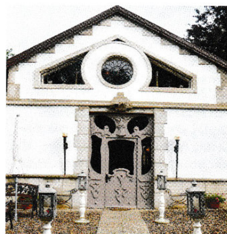
Schöne Fassade und einladender Eingangsbereich.
